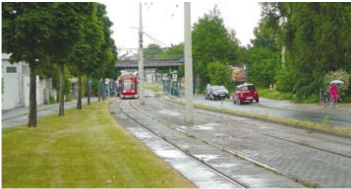
Die Straßenbahnhaltestelle am Gliesmaroder Bahnhof würde nach dem Umbau auch von Bussen angefahren werden
