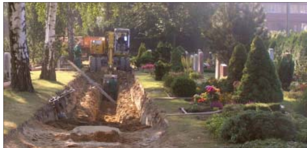
Mit Drainagearbeiten auf dem Friedhof haben die Arbeiten zur Erweiterung begonnen.
