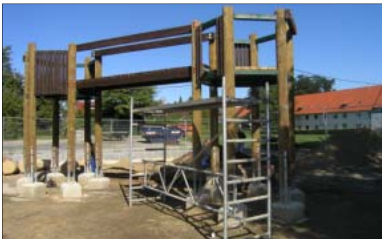
Hier entsteht das neue Klettergerüst mit Rutsche, Kletternetz und Feuerwehrleiter. Foto: GS Lindbergsiedlung
