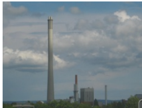
Der 1983 erbaute 198 Meter hohe Schornstein des Heizkraftwerkes, ist das höchste Bauwerk in Braunschweig.
