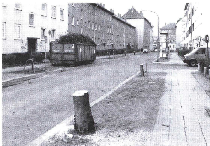
Die Uhlandstraße nach den Baumfällarbeiten am 17. Februar dieses Jahres.
