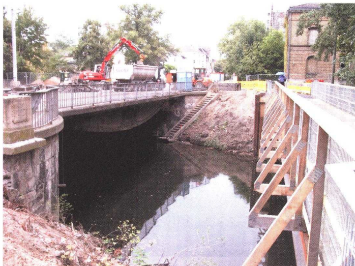
Alt neben neu. Die Fallersleber Tor-Brücke kurz vor ihrem Abriss; Rechts daneben die Behelfsbrücke.
