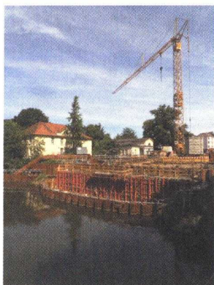
Still-leben mit Kran. Die Großbaustelle am Fallersleber Tor.
