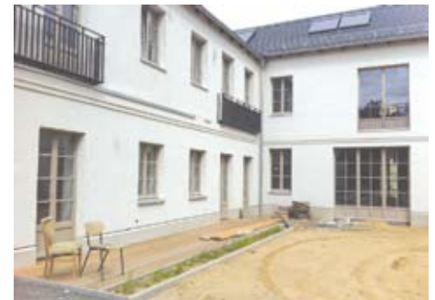
Auf dem Foto die bereits sanierte, ehemalige Schlosserwerkstatt von Draht-Thein.
