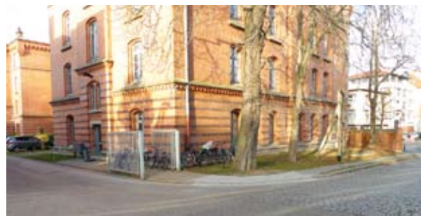
Im Erdgeschoss der ehemaligen Mars-Latour-Kaserne, Altwiekering 20c, befindet sich die Räume des lab
