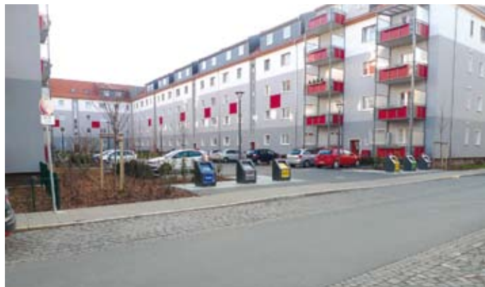
Blick auf die Einwurfschächte für die versenkten Müllcontainer in der Heinrich-Heine-Straße
