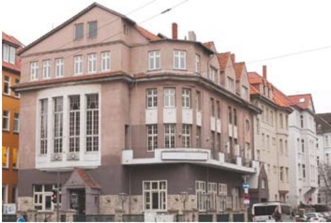
Der 1908 erbaute Lindenhof
