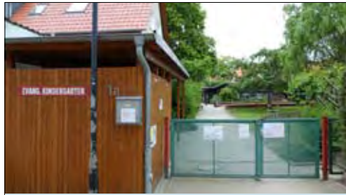
Der Eingangsbereich der Kita Mascherode.
