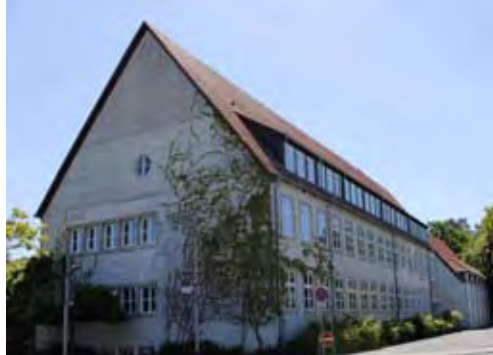
Grundschule Mascheroder Holz
