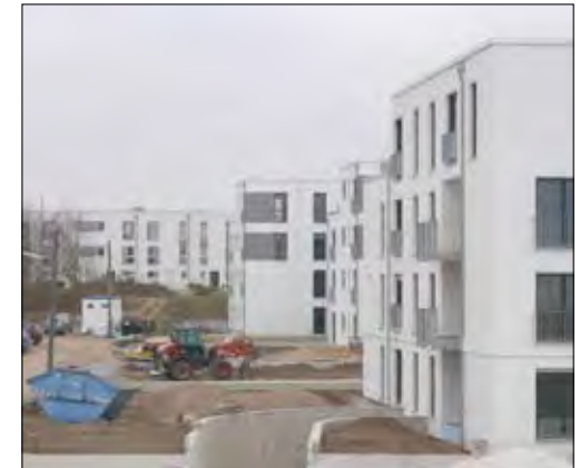
Im Baugebiet Heinrich-der-Löwe entstehen statt 400 jetzt 695 Wohneinheiten.
