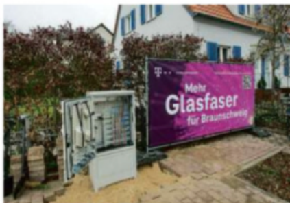
Glasfaser für Braunschweig: rund 30.500 Haushalte sollen im Jahr 2021 schnelles Internet bekommen.
