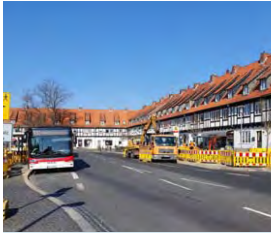
Die Umbauarbeiten am Welfenplatz für das Fahrgastinformationssystem erfolgten binnen weniger Tage Ende April.
