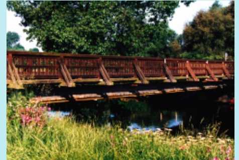
Der Baubeginn der Brücke in Leiferde lässt noch auf sich warten - ist aber beschlossen. Provisorische Fußgängerbrücke während der Bauzeit kommt.
