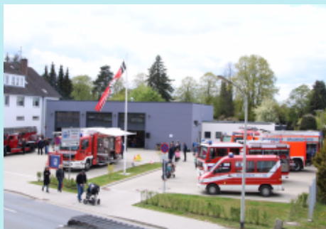
Neubau des Feuerwehrhauses in Leiferde - ein großer Gewinn. Die Sicherheit und das Ehrenamt liegt uns am Herzen.
