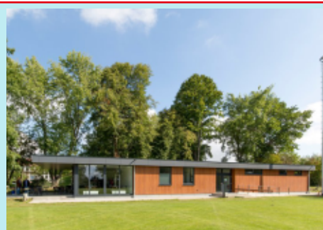
Der VfL Leiferde bekommt ein neues Sportheim , so viel steht fest. Der aktuelle Zustand mit Duschen und Toiletten im Keller der Schule hat bald ein Ende.
