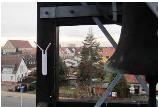
Über wetterfeste Antennen werden die Außenanlagen um die Kirchen mit WLAN versorgt. Foto: Weitner-von Pein
