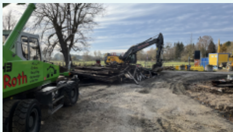
Demontage der Fischerbrücke
